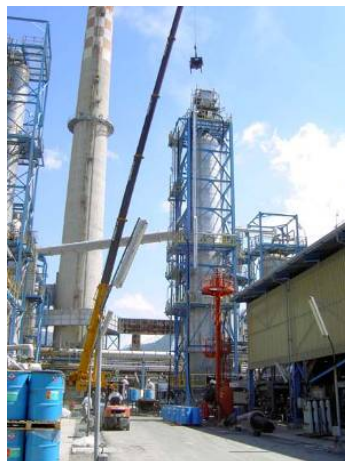
Une grue charge le catalyseur à l'aide d'une trémie
