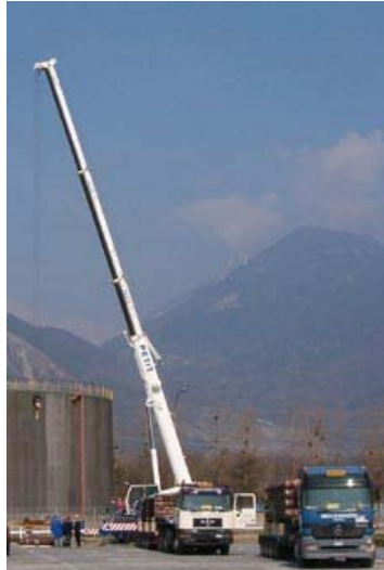
Déchargement des modules
